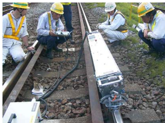
本線ガードレール区間の削正 (兼用型) (GP・GS 溶接、普通継目、溶接継目、分岐継目、接着絶縁継目)
