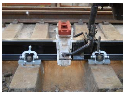
② キャンバー調整ネジ ② 締結装置ブロック ③ 通り調整ネジ
