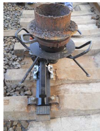
② キャンバー調整ネジ ② 締結装置ブロック ③ 通り調整ネジ
