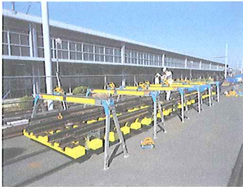
(施工イメージ)
