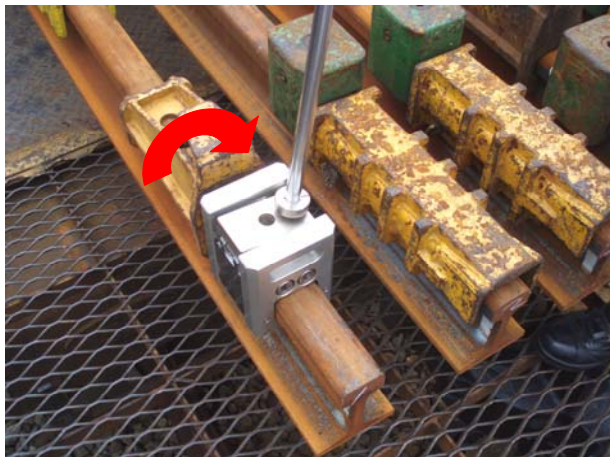
固定金具取付
