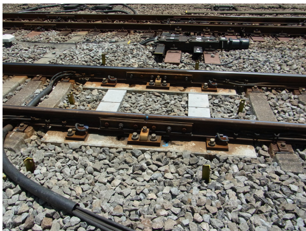
敷設事例（普通絶縁継目 左写真：3締結 右写真：5締結）
