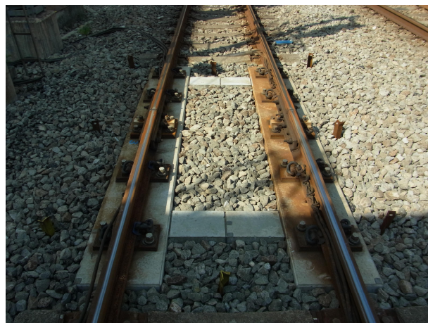
敷設事例（普通絶縁継目 左写真：3締結 右写真：5締結）
