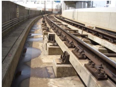
図2 フローティング・ラダー軌道 断面図
