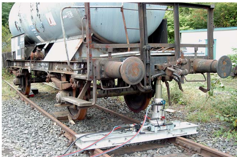
ジャッキ1本掛の脱線復旧
