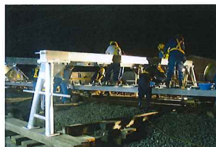
ラダーマクラギ横移動作業
