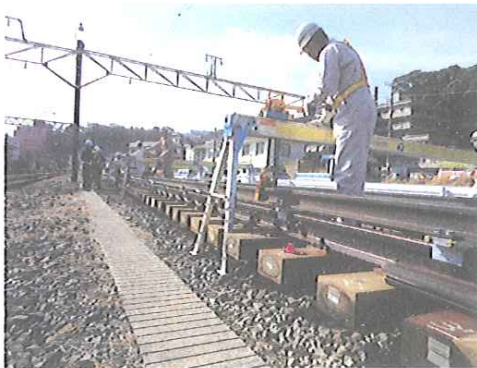
分岐器・道レール (37k) キャッチ取付例
