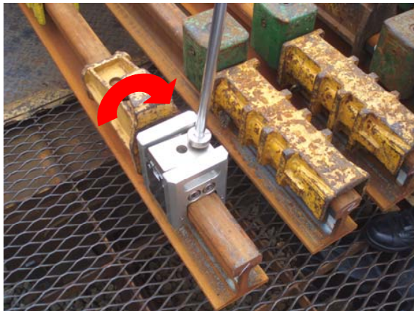
固定金具取付
