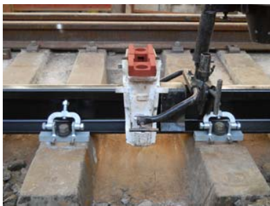
② キャンバー調整ネジ ② 締結装置ブロック ③ 通り調整ネジ
