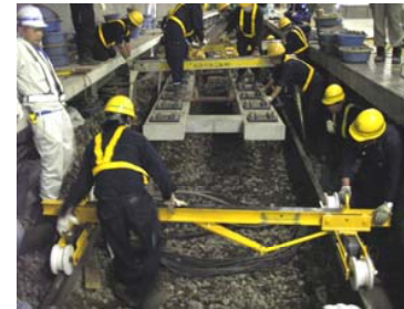
山越器にて据付中
