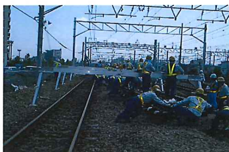
次世代分岐横移動作業
