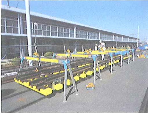
(施工イメージ)
