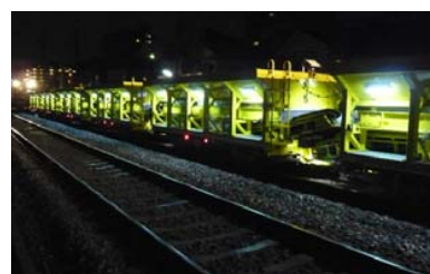
LED照明で車輛が明るい
