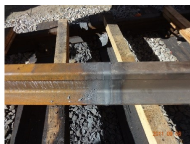
溶接後の状況
