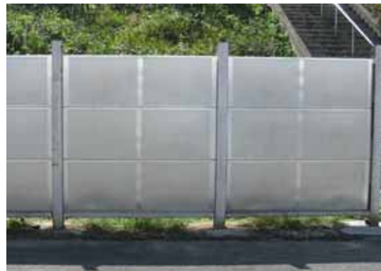
アンカーボルト方式（既設壁取付型）
