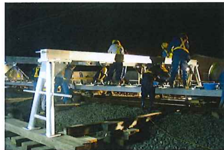
ラダーマクラギ横移動作業
