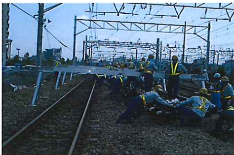
次世代分岐横移動作業
