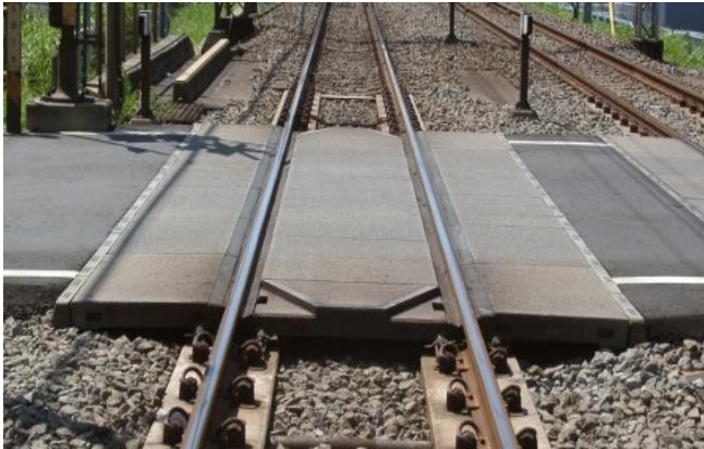
ラダーボーダン踏切
