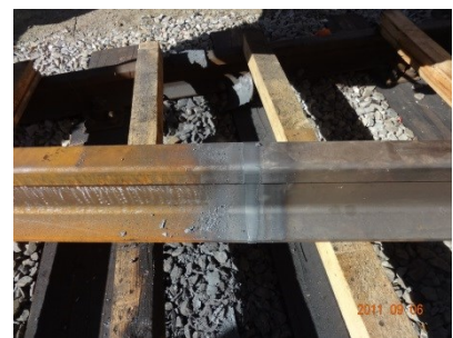
溶接後の状況
